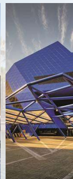
EDIFÍCIOS DE LAZER
