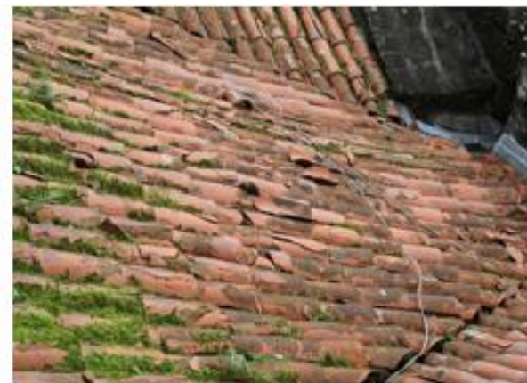
Degradação por ação do gelo.
