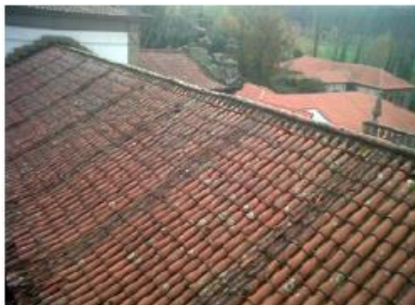
Pendente com rebentamentos.
